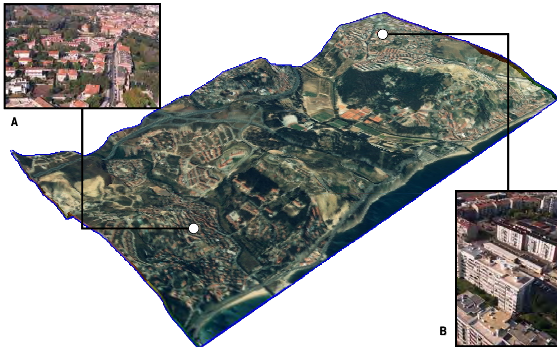
Figura 5.2 – Perspectiva aérea da área de estudo (exageração vertical 3x), com destaque para as zonas de habitação unifamiliar (A) e plurifamiliar (B)
