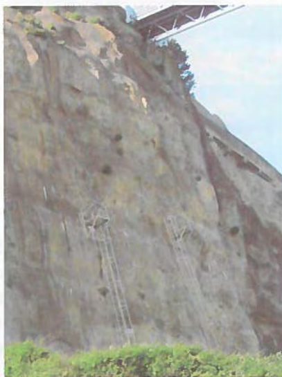
Figura 36 – Consolidação da arriba, Boca do Vento
