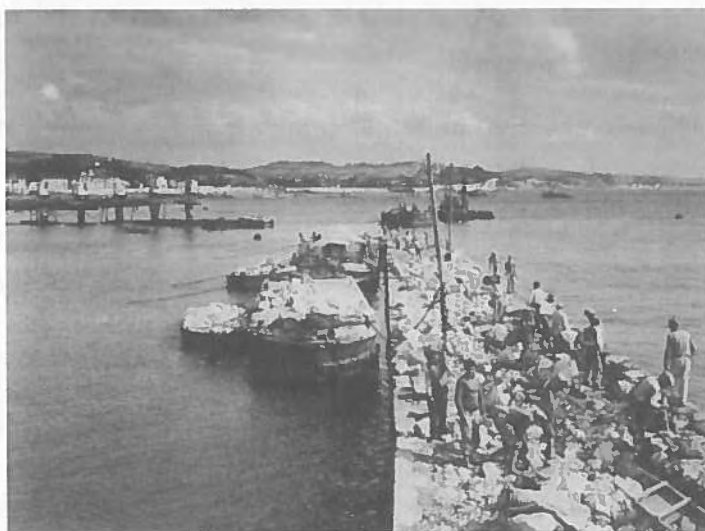
Figura 6 – Obras no Porto de Lisboa
