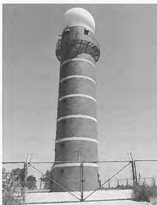
Fig.2.22 – Fotografia do RADAR meteorológico do IM, I.P. instalado em Loulé na Serra do Caldeirão. (Autor: Sandra Correia)
