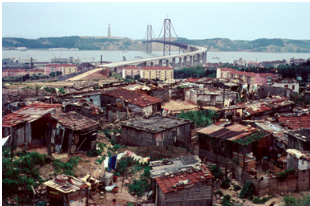
FIG. 5 Perspectiva do acesso à “Ponte Salazar” em Lisboa, Abril de 1966
