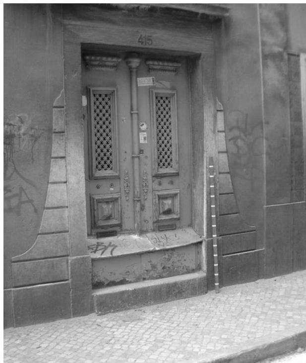
8 – Reforço em metal da base de porta de madeira, para evitar a sua degradação pela água, na Estrada de Benfica. Cada traço da escala representa 10 cm.
