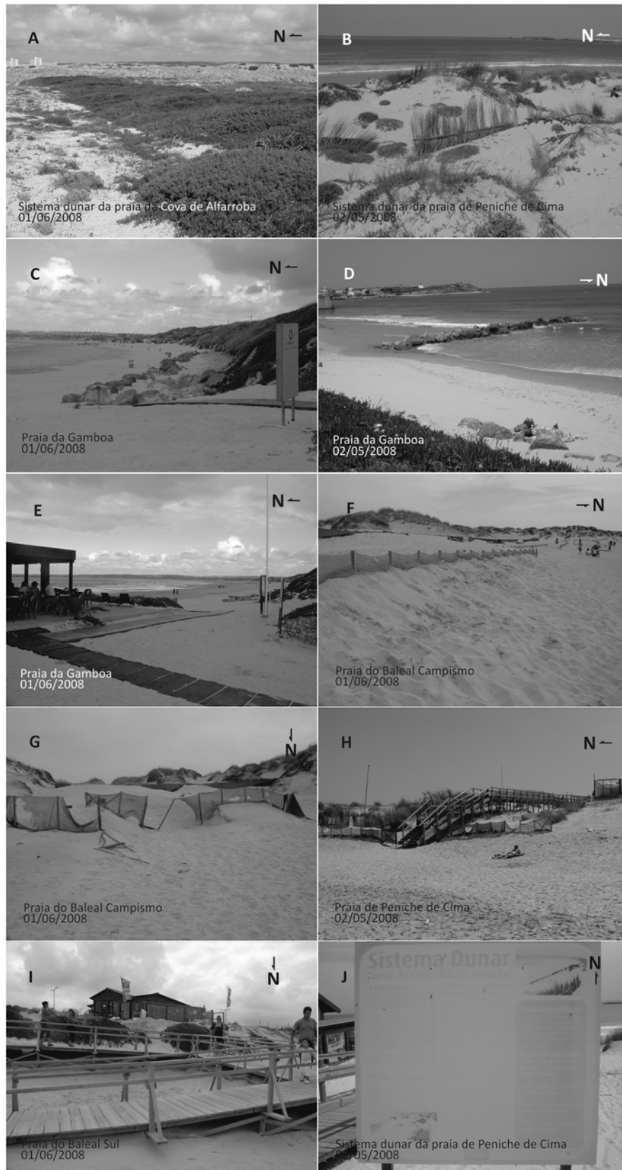
Fotos 3.7. Alinhamento de vegetação (A); Armadilhas de areia construídas com caniços (B); Enrocamento da base da duna artificial (C); Esporão (D); Estrados de plástico e madeira junto a um apoio de praia (E); Armadilhas de areia de malha sintética (F e G); Escadas e passagem sobrelevadas (H e I); Paineiro informativo (J). Localização das fotos na Figura 3.21.
