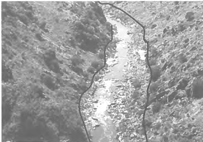
FIGURA. 24 – O leito de cheia, dado pela linha de lavagem, no vale do Rio Cõa.
